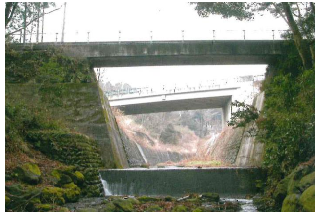
おおくぼざわ かけどい 本妙寺北にある大久保沢の掛樋 昔は木製だったが、今はコンクリートです
